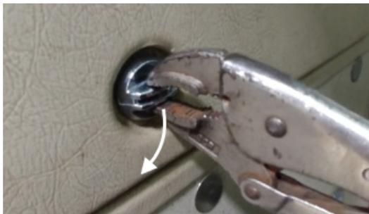
4. Élargir l'ouverture intérieure de la porte pour insérer le corps de la nouvelle serrure.
