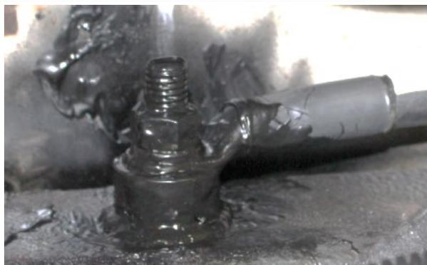
FIGURE 82 : BORNE DE MASSE AVEC REVÊTEMENT DE CAOUTCHOUC
