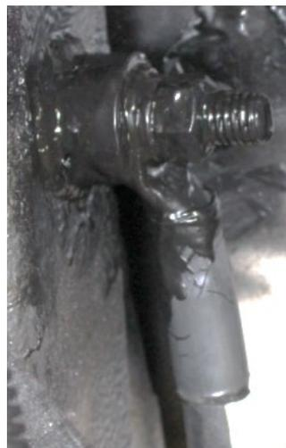
FIGURE 124 : BORNE DE MASSE AVEC REVÊTEMENT DE CAOUTCHOUC
