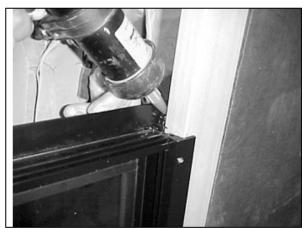
FIGURE 69 : AWNING WINDOW - SEAL THE UPPER CORNERS
