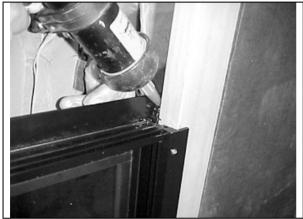
FIGURE 75 : SLIDING WINDOW - SEAL THE UPPER CORNERS
