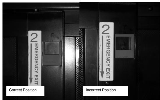
FIGURE 26: RELEASE LATCH PROPER POSITION
