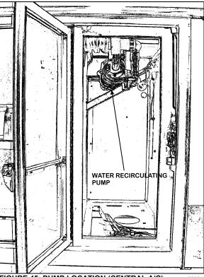
FIGURE 45: PUMP LOCATION (CENTRAL A/C)
