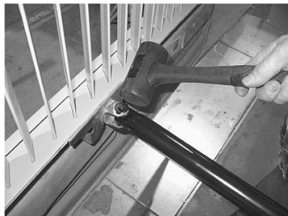
FIGURE 64 AJUSTEMENT LATÉRAL DE LA PORTE
