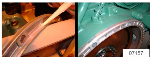
FIGURE 11: INSTALLATION DE L'ENTRETOISE D'ESPACEMENT
