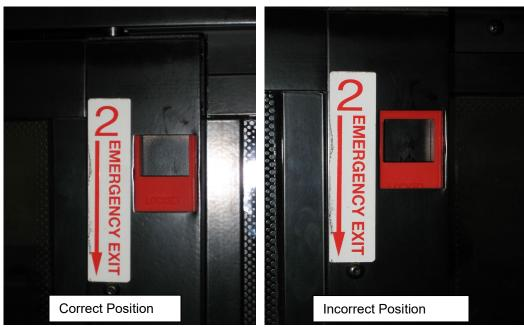
FIGURE 51: RELEASE LATCH PROPER POSITION
