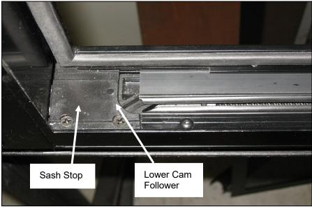
**FIGURE 109: PROPER ALIGNMENT**
