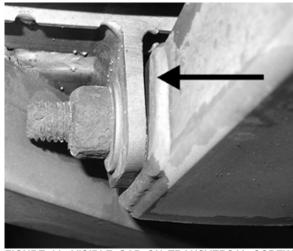
FIGURE 28: VISIBLE GAP ON TRANSVERSAL SCREW JOINT
