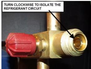
FIGURE 67: REFRIGERANT CIRCUIT SHUT-OFF VALVE
