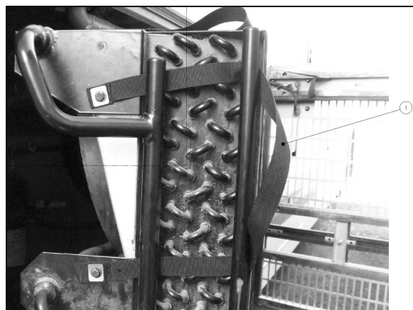
SANGLE DE L'ENSEMBLE DE CONDENSEUR
