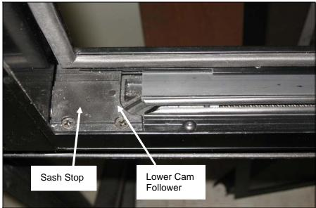
**FIGURE 66: PROPER ALIGNMENT**
