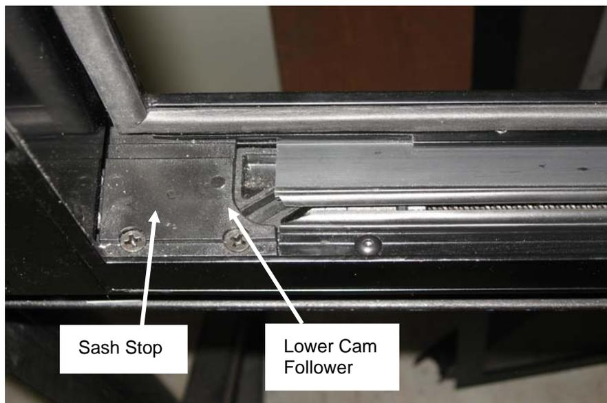
FIGURE 43: PROPER ALIGNMENT
