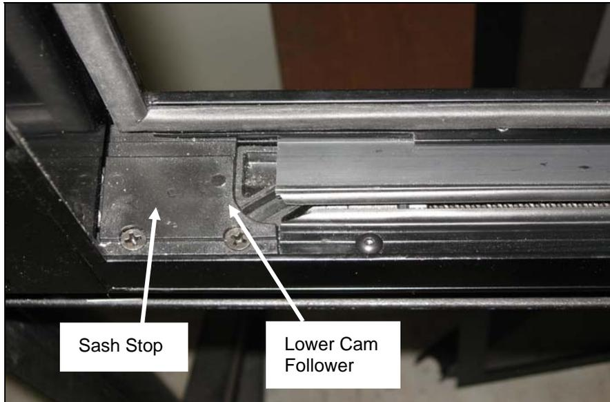
**FIGURE 66: PROPER ALIGNMENT**
