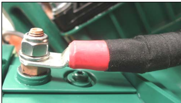
Figure 16: Aucun brin de cuivre apparent.
