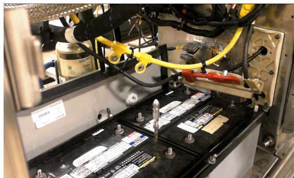
FIGURE 45: DÉGAGEMENT DES CÂBLES
