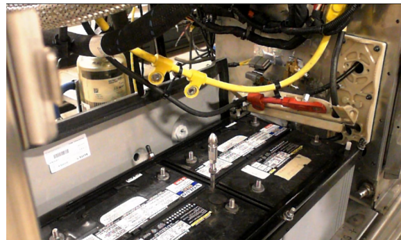
FIGURE 45: DÉGAGEMENT DES CÂBLES
