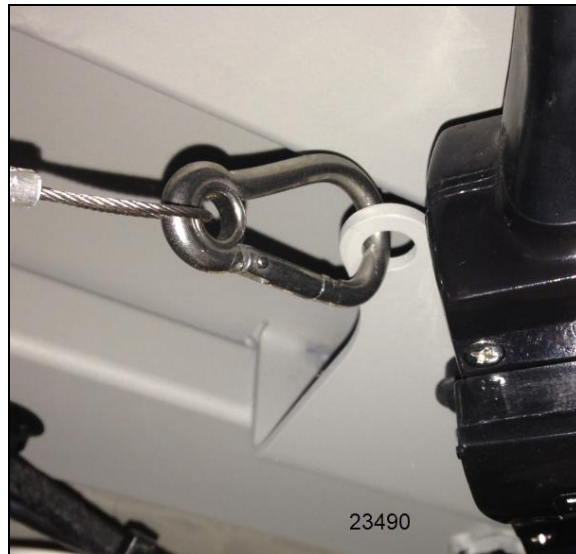
FIGURE 56: INSTALLATION DU CÂBLE DE SÛRETÉ
