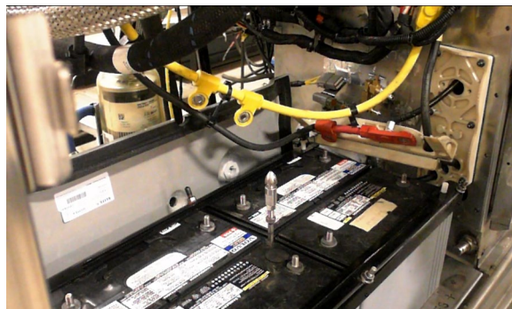
FIGURE 45 DÉGAGEMENT DES CÂBLES
