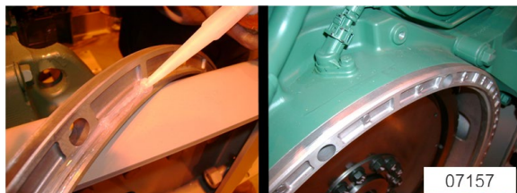
FIGURE 11: INSTALLATION DE L'ENTRETOISE D'ESPACEMENT
