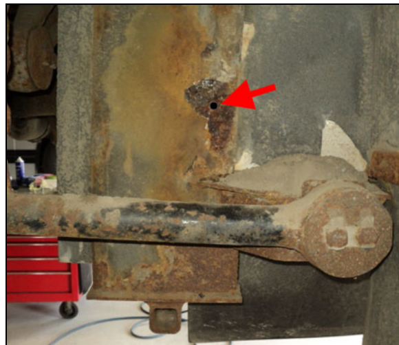
FIGURE 7: TROU PERCÉ DANS LE CHÂSSIS
