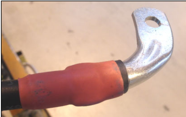
Figure 17: Le câble de puissance ne doit pas être plié de façon excessive juste avant la cosse. Utiliser une cosse coudée pour éviter les contraintes mécaniques.
