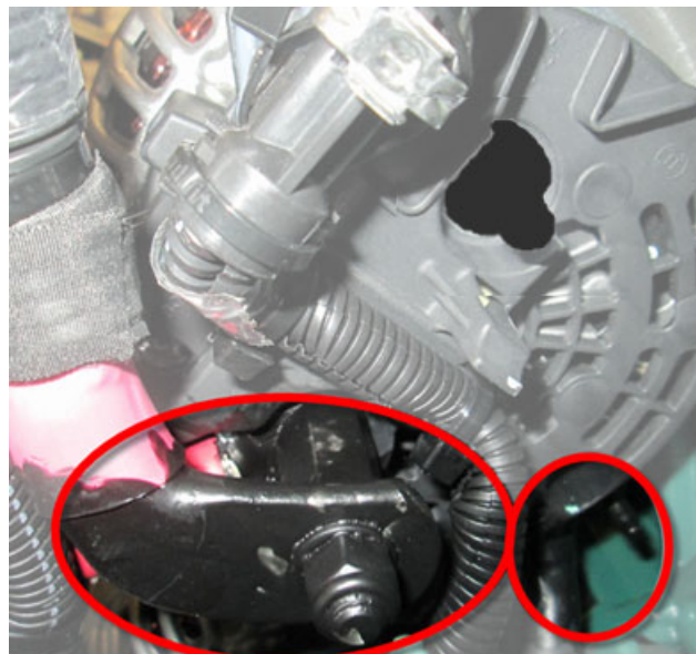
Figure 28: Cosse de câble de l'alternateur inférieur protégé avec le revêtement de protection Color Guard.
