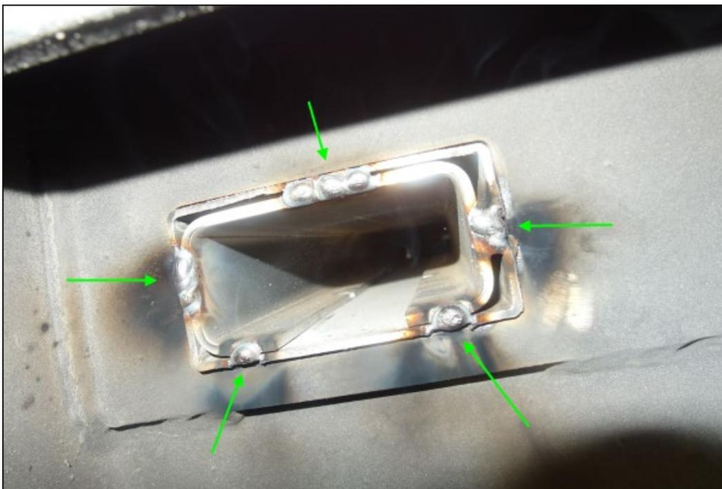
11. Souder en longueur la fissure précédemment élargie en s'assurant d'une pénétration adéquate entre le pilier et le renfort.
