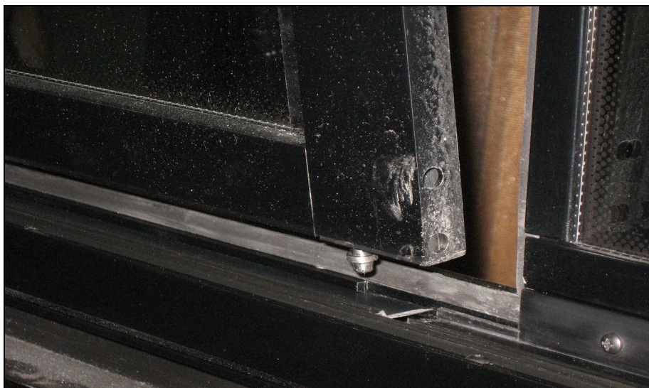
FIGURE 103: DÉGAGEMENT DU BAS DU CHÂSSIS
