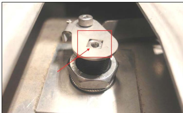
15. Fixer le loquet à la tige de poignée à l'aide de la vis de la rondelle et de la rondelle de blocage fournies (5001377, 5001137 et 5001544).
