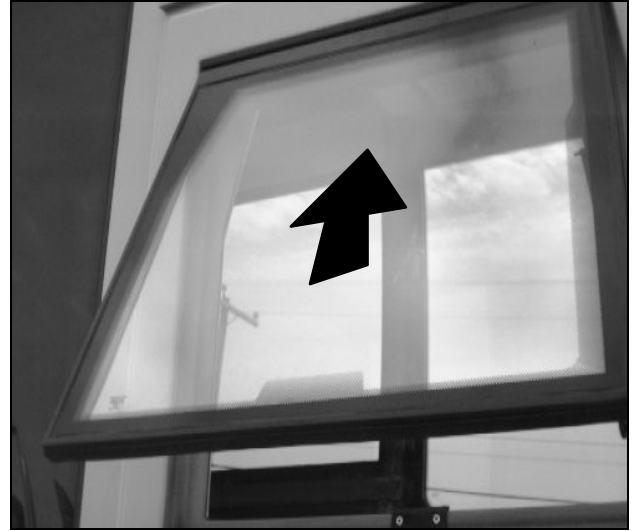
FIGURE 2: DÉCROCHAGE ET ACCROCHAGE DE LA FENÊTRE SUR LA PORTE
