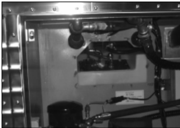
FIGURE 2: PANNEAU D'ACCÈS ENLEVÉ.
