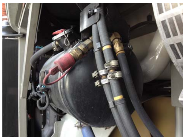
NOUVEAU RÉSERVOIR D'EXPANSION – COTÉ TROTTOIR
