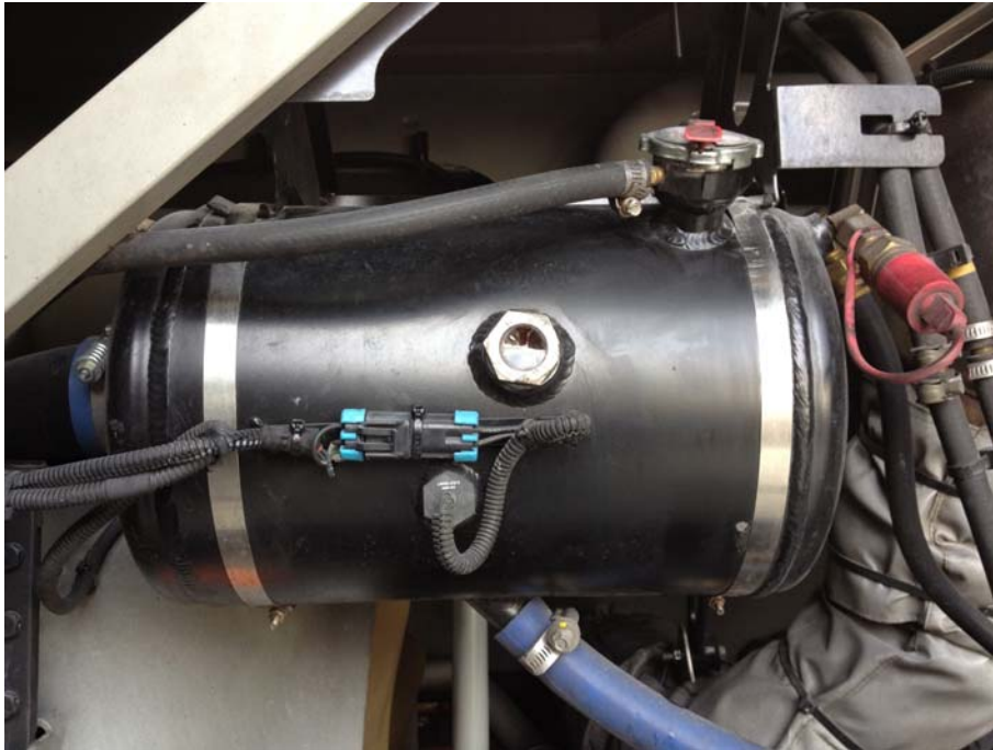
NOUVEAU RÉSERVOIR D'EXPANSION INSTALLÉ
