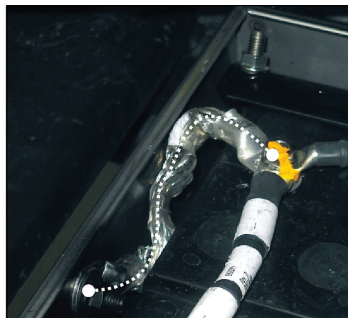
Figure 10 : Mise à la terre Série X
