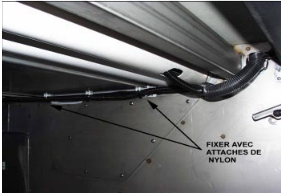
Figure 9 : Fixer le faisceau # 065264 et les fils 41A, 41B, 42A & 0D le long du plafond du compartiment à bagages avec des attaches de nylon
