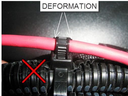
Serrage excessif de l'attache de nylon sur le LTD. Serrer la boucle du LTD à la main seulement. Effectuer le serrage nécessaire pour éviter que le LTD puisse glisser dans la boucle sans plus.
