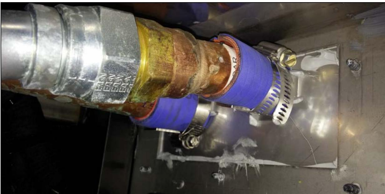
14. Revérifier que toutes les ouvertures autour de la plaque et des conduites sont bien scellées par l'adhésif (étendre et/ou ajouter de l'adhésif au besoin pour compléter l'installation).
