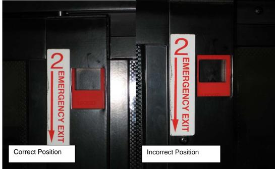
FIGURE 68: RELEASE LATCH PROPER POSITION
