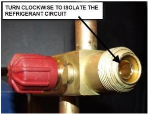
FIGURE 45: REFRIGERANT CIRCUIT SHUT-OFF VALVE
