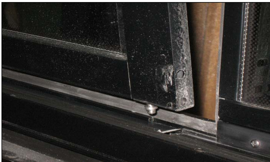
FIGURE 65 : DÉGAGEMENT DU BAS DU CHÂSSIS
