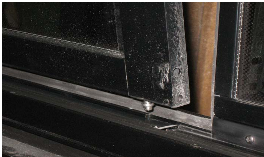
FIGURE 42 : DÉGAGEMENT DU BAS DU CHÂSSIS
