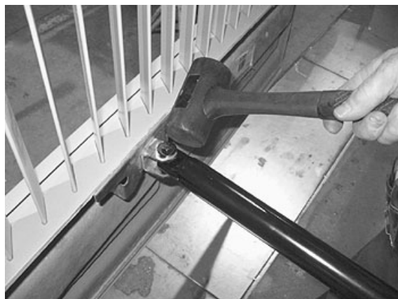
FIGURE 64 : AJUSTEMENT LATÉRAL DE LA PORTE
