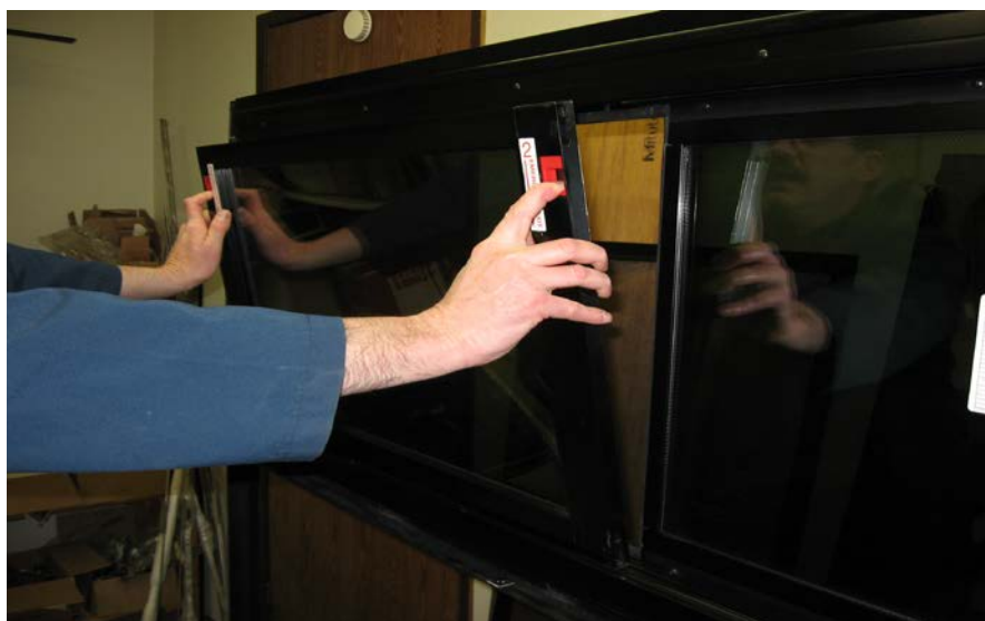
FIGURE 41 : RETRAIT DU CHÂSSIS
