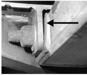
FIGURE 41: VISIBLE GAP ON TRANSVERSAL SCREW JOINT
