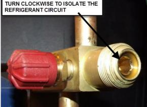
FIGURE 67: REFRIGERANT CIRCUIT SHUT-OFF VALVE
