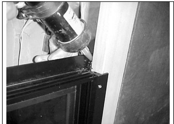
FIGURE 75: SLIDING WINDOW – SEAL THE UPPER CORNERS
