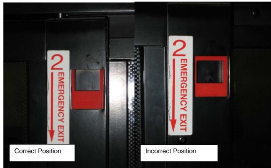
FIGURE 68: RELEASE LATCH PROPER POSITION
