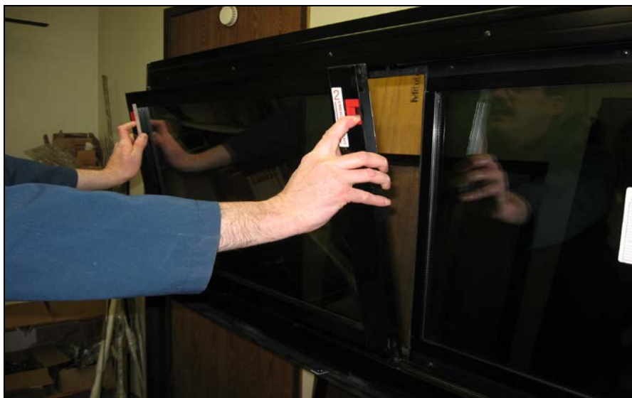
FIGURE 64 : RETRAIT DU CHÂSSIS
