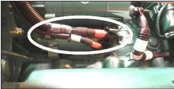
Figure 5: Câbles du démarreur
