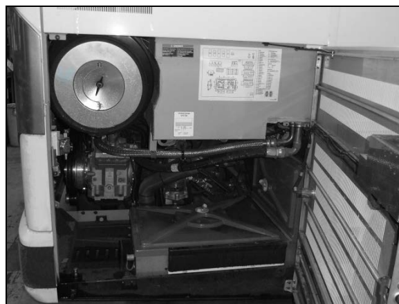
CÔTÉ DROIT DU MOTEUR 18607
