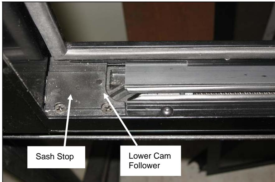
**FIGURE 66: PROPER ALIGNMENT**
