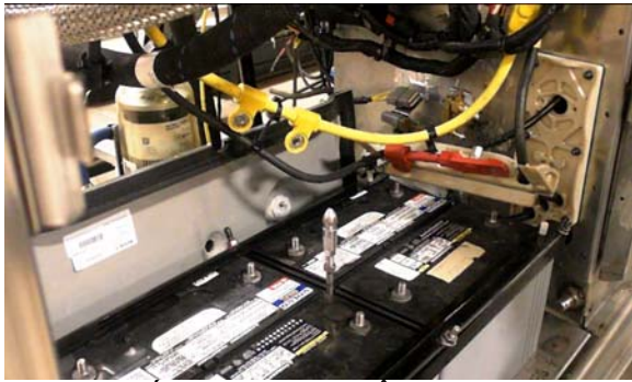
FIGURE 33 DÉGAGEMENT DES CÂBLES
