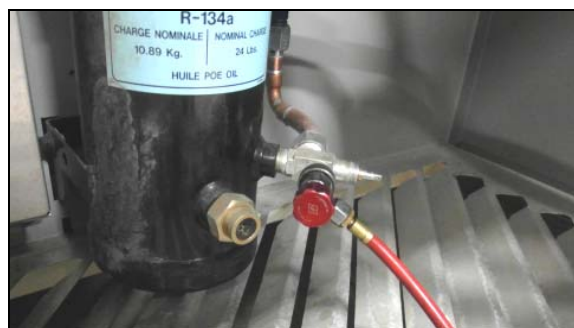
FIGURE 78 : UNITÉ DE RÉCUPÉRATION CONNECTÉE AU RACCORD DE SERVICE DU RÉSERVOIR DE STOCKAGE
