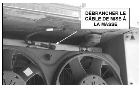
FIGURE 25: CÂBLE DE MISE À LA MASSE DU SYSTÈME DE REFROIDISSEMENT
