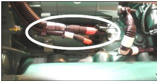
Figure 5: Câbles du démarreur
