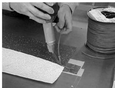
8. Le talon de la buse rapide ne doit pas toucher le revêtement de plancher (il doit toujours être parallèle à la surface).
