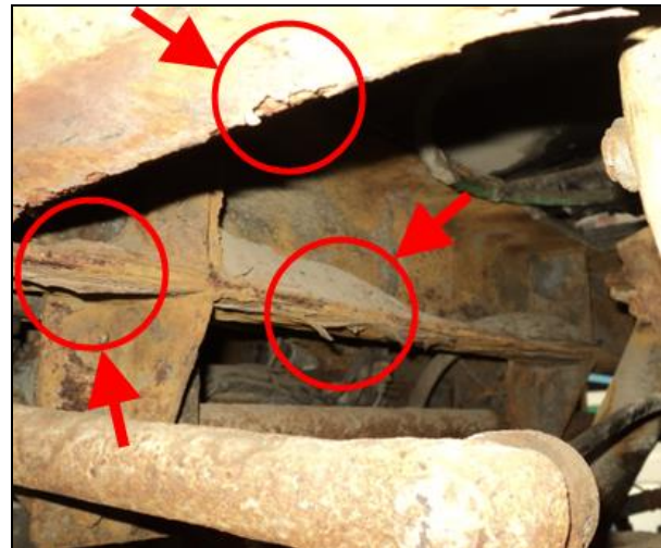
FIGURE 3: ÉCAILLAGE DU MÉTAL ET ACCUMULATION DE SABLE
