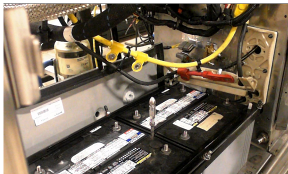
FIGURE 45: DÉGAGEMENT DES CÂBLES
