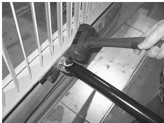
FIGURE 64 AJUSTEMENT LATÉRAL DE LA PORTE
