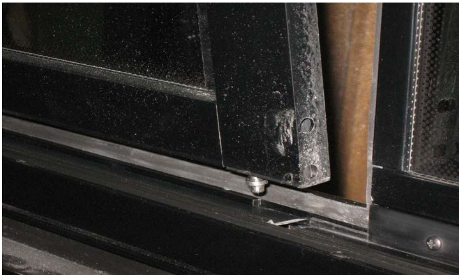
FIGURE 42: DÉGAGEMENT DU BAS DU CHÂSSIS
