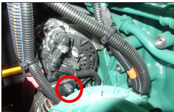
Figure 20: S'assurer que les câbles de puissance ou câbles positifs (+) sont bien fixés aux bornes des alternateurs et que les écrous sont bien serrés.
