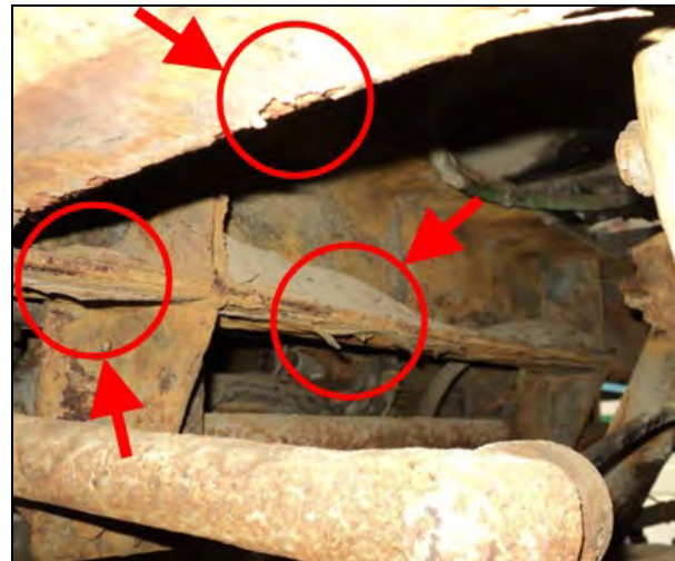
FIGURE 3: ÉCAILLAGE DU MÉTAL ET ACCUMULATION DE SABLE
