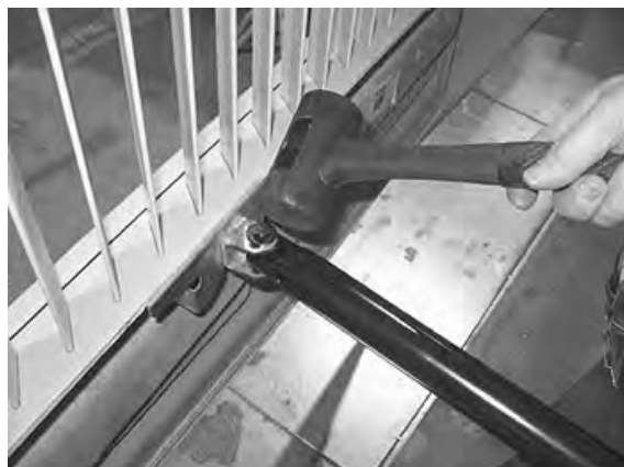
FIGURE 67 AJUSTEMENT LATÉRAL DE LA PORTE
