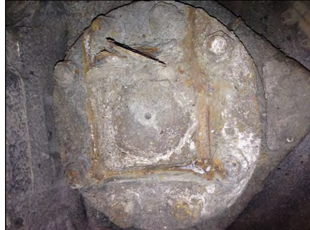
FIGURE 5: AUTOCAR FORTEMENT CORRODÉ AVEC UNE ROUE DE L'ESSIEU AUXILIAIRE CASSÉE. CETTE IMAGE MONTRE LA PLAQUE DE MONTAGE DE LA FUSÉE SÉPARÉE DU RESTE DE L'ESSIEU
