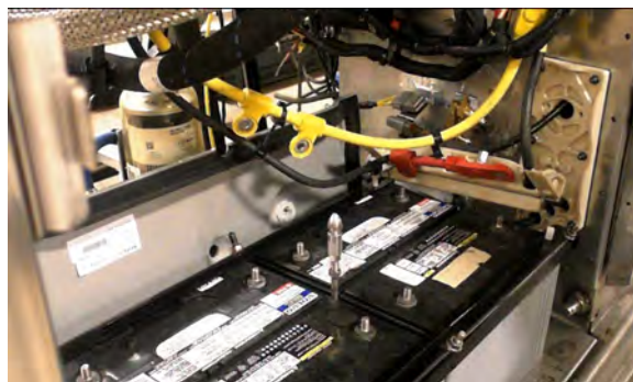
FIGURE 45 DÉGAGEMENT DES CÂBLES
