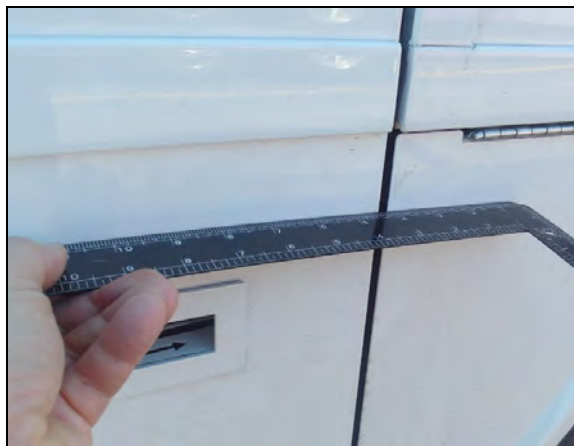
FIGURE62: UTILISER UNE RÈGLE POUR VÉRIFIER SI LES SURFACES SONT AU MÊME NIVEAU
