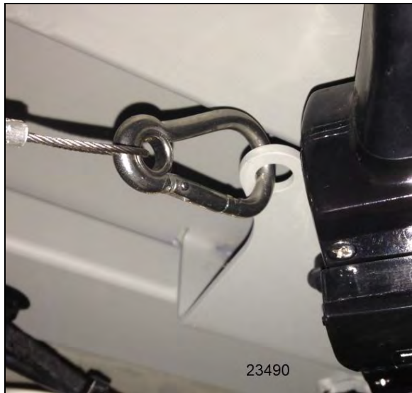
FIGURE 54: INSTALLATION DU CÂBLE DE SÛRETÉ
