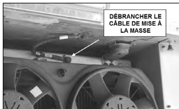
FIGURE 32: CÂBLE DE MISE À LA MASSE DU SYSTÈME DE REFROIDISSEMENT
