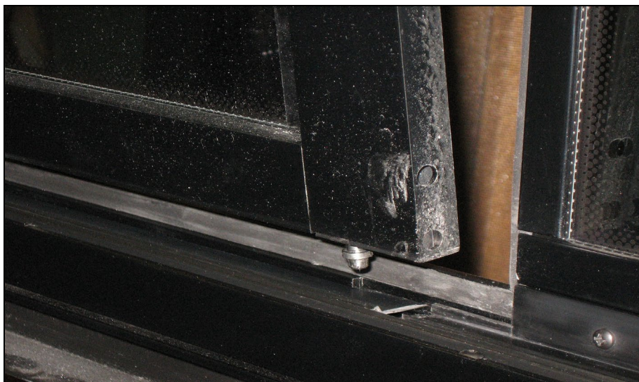
FIGURE 104: DÉGAGEMENT DU BAS DU CHÂSSIS
