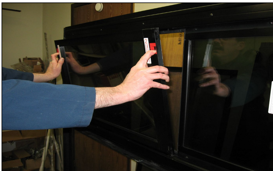
FIGURE 103: RETRAIT DU CHÂSSIS
