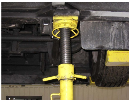
FIGURE 18: CHANDELLE AU SUPPORT DE LEVAGE - À L'ARRIÈRE DE L'ESSIEU AVANT, CÔTÉ TROTTOIR
