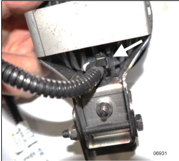
FIGURA 101: INSTALACIÓN DE LA LUZ ANTINIEBLA
