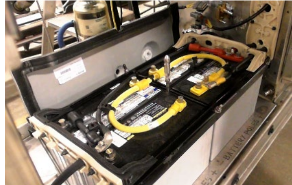
FIGURA 42: CUBIERTA DEL BANCO DE BATERÍAS RETIRADA
